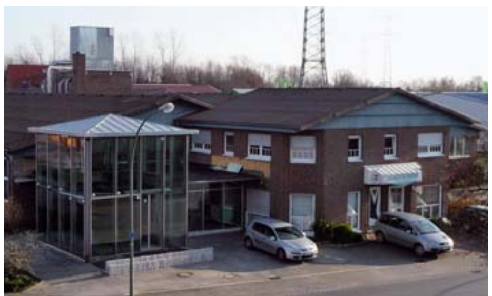
Die Tischlerei verfügt über rund 3000 Quadratmeter Produktionsfläche. Im Rohbau fertig ist der neue, vollverglaste Ausstellungsbereich, in dem das Unternehmen demnächst spannende Exponate zeigen wird
