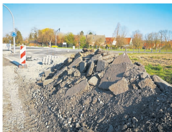
In großen Haufen türmt sich der alte Asphalt der Münsterstraße, die derzeit saniert wird. Foto: Christian Wolff
